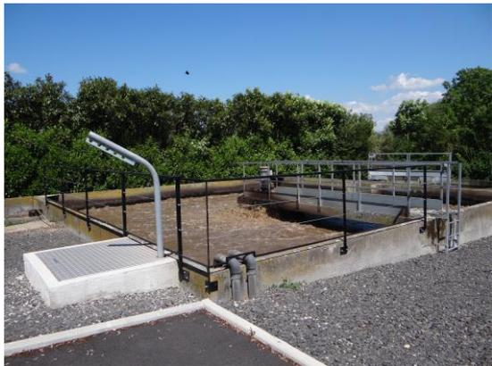
Des travaux de mise en sécurité de la station d'épuration ont été réalisés avec la pose d'une main courante le long du bassin d'aération ainsi qu'un caillebotis sur le puits de relevage pour un montant de 2 188 €
