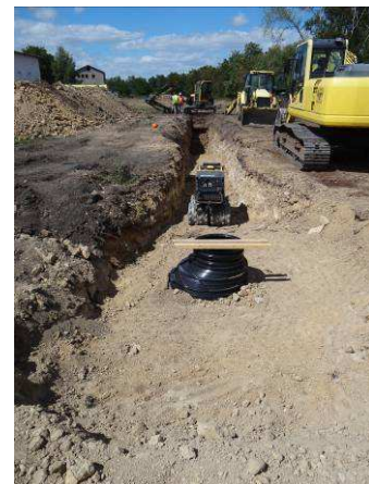
Travaux d'assainissement sur le carreau de la mine pour le branchement des futures habitations du lotissement, des bâtiments existants et pour prévoir de décharger la station de relevage du Diolet
