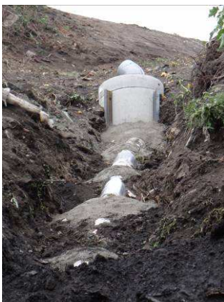
Aménagement d'un bassin d'orage en haut du carreau de la mine récupérant les eaux pluviales du futur lotissement et de l'allée des Marronniers. Il permettra de réguler l'évacuation de ces eaux vers l'Allagnon
