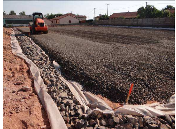
Réalisation d'un parking de 50 places pour le stationnement du lotissement du carreau de la mine, des riverains de la rue du Puy S t Alexandre et utilisateurs du quartier commercial
