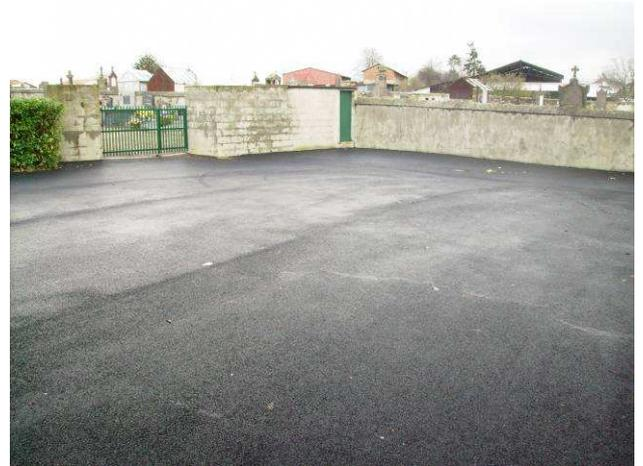
Rénovation du parking et de son accès avec enrobé et récupération des eaux pluviales au réseau
