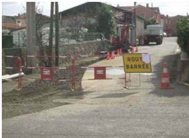
Travaux d'assainissement Rue du Marché pour la construction d'une habitation individuelle.
