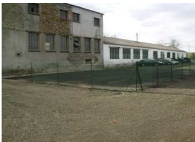
Réalisation d'une plateforme, d'une part pour le garage Jacquemont, et d'autre part pour le stockage de l'entreprise Auvergne granulés bois installée récemment sur le Carreau de la Mine.
