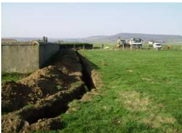
Mise en place d'un drainage côté ouest du cimetière, pour essayer de pallier au problème d'eau dans les caveaux.
